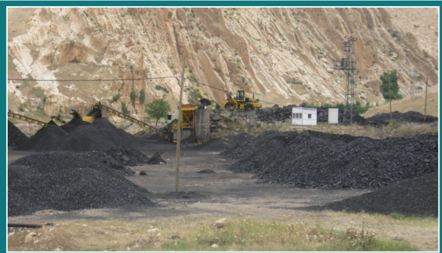
Resim.4B Şırnak Maden Sahası Asfaltit Damarı ve Kırma-Eleme Tesisi
